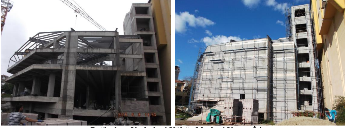
Bağlarbaşı Yerleşkesi Kültür Merkezi Yapım İşi
